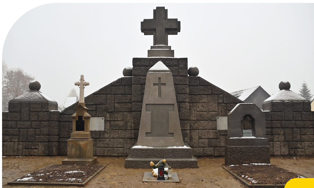
Beneficjent: Gmina Brzesko Zadanie: Remont konserwatorski cmentarza z I wojny światowej nr 273 w Szczepanowie Wartość dotacji: 15 000 złotych, koszt całkowity zadania: 152 520 złotych fot. archiwum UMWM
