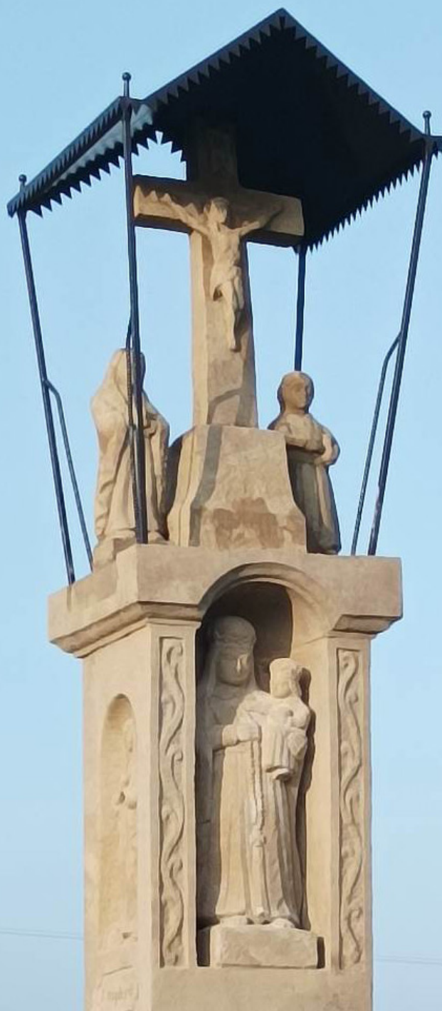
Beneficjent: Gmina Raciechowice Zadanie: Kompleksowa konserwacja filarowej, kamiennej kaptliczki przydrożnej z 1882 r. z figurą Najświętszej Marii Panny w miejscowości Kwapinka Wartość dotacji: 10 000 złotych, koszt całkowity zadania 38 868 złotych Fot. archiwum UMWM
