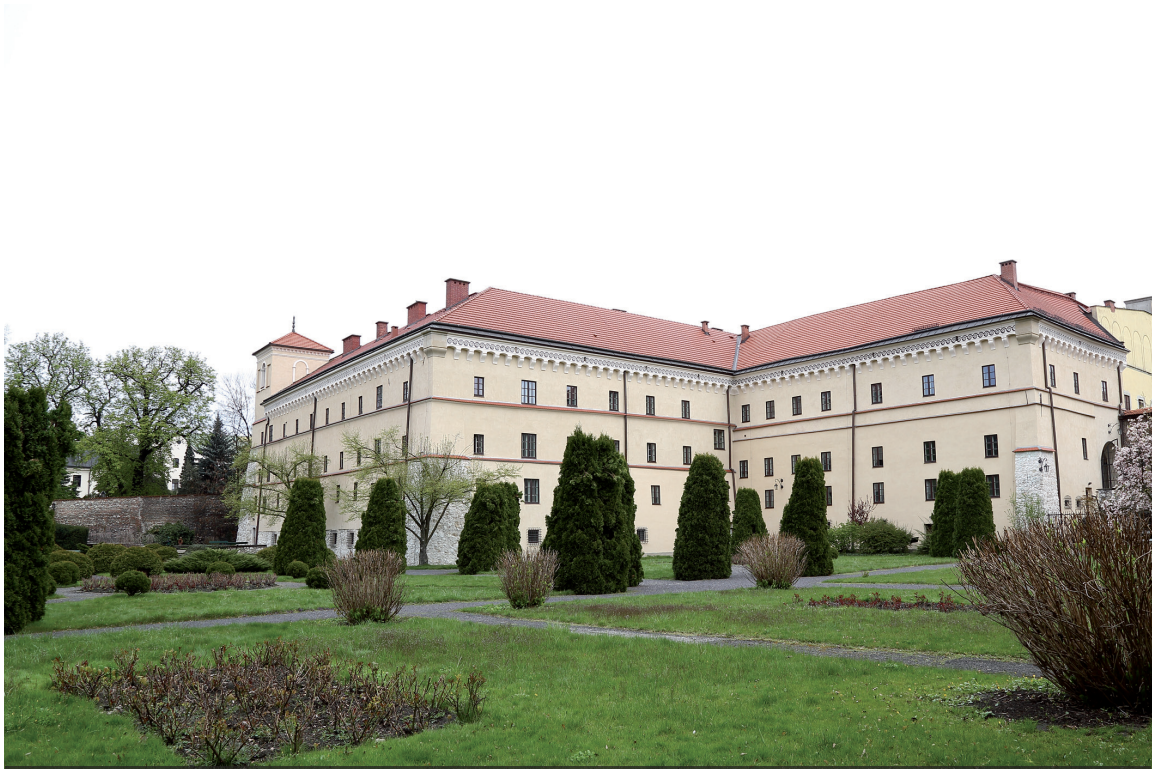
Muzeum Archeologiczne w Krakowie, wyremontowana elewacja budynku
