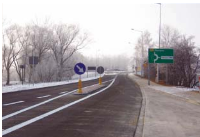
Przebudowa ulicy Legionów w Oświęcimiu
