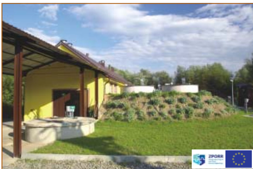
Rozbudowa oczyszczalni ścieków i kanalizacji sanitarnej w gminie Laskowa
