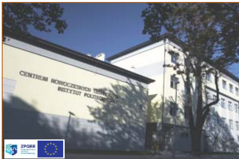
Budowa obiektu dla potrzeb Centrum Nowoczesnych Technologii – Instytut Politechniczny Państwowa Wyższa Szkoła Zawodowa w Tarnowie
