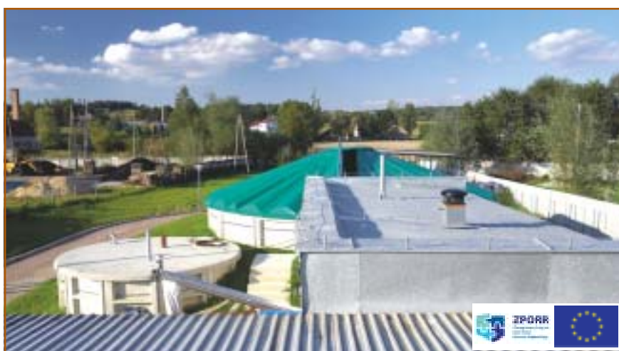
Modernizacja i rozbudowa oczyszczalni ścieków w miejscowości Kobylec gmina Łapanów
