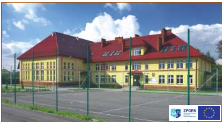
Gimnazjum, sala gimnastyczna z zapleczem i salami dydaktycznymi w Trzcianie
