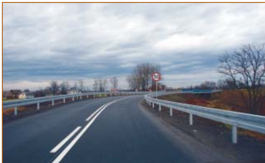
Budowa drogi w miejscowości Strzelce Małe
