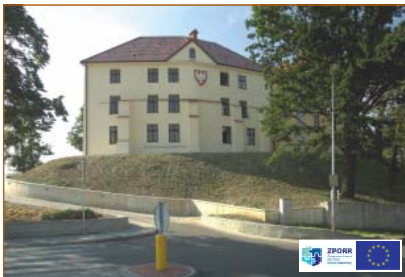
Remont i adaptacja Zamku Piastowskiego w Oświęcimiu
