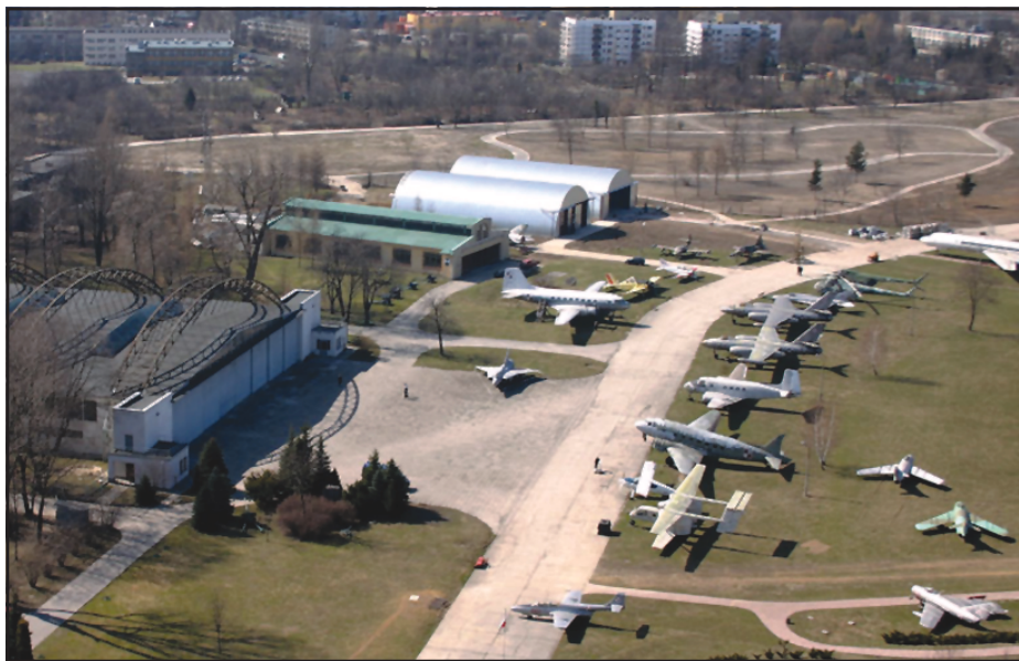
Lotniczy Park Kulturowy w Krakowie – modernizacja hangarów
