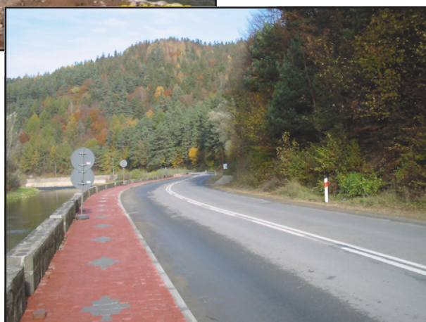
ZDW – chodnik przy drodze 971 w miejscowości Piwniczna
