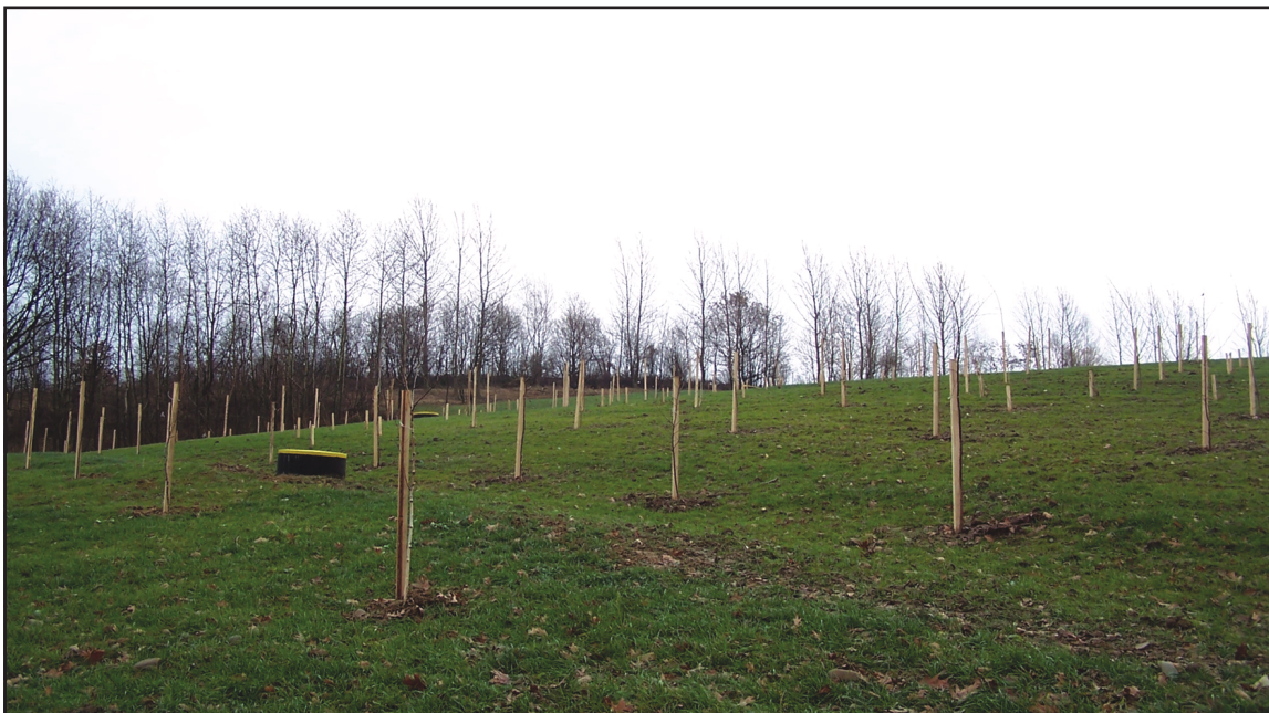
Rekultywacja składowiska odpadów komunalnych w Dobczycach
