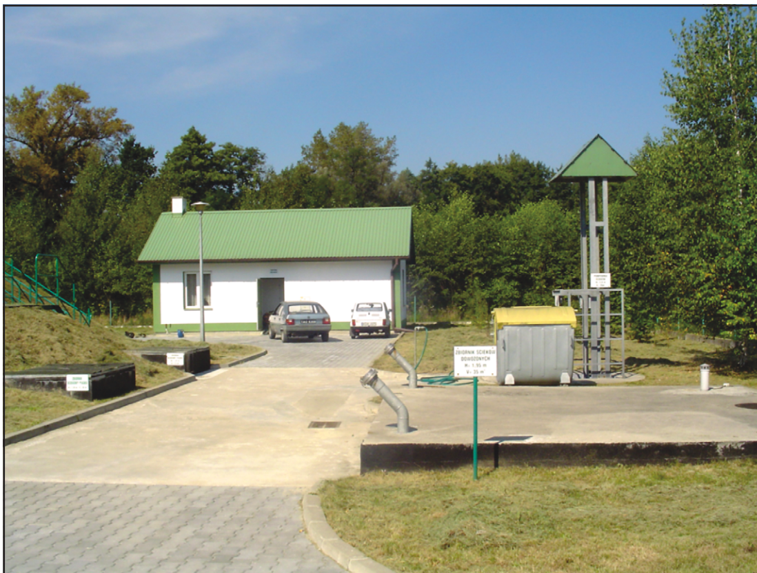
Oczyszczalnia ścieków w gminie Radgoszcz
