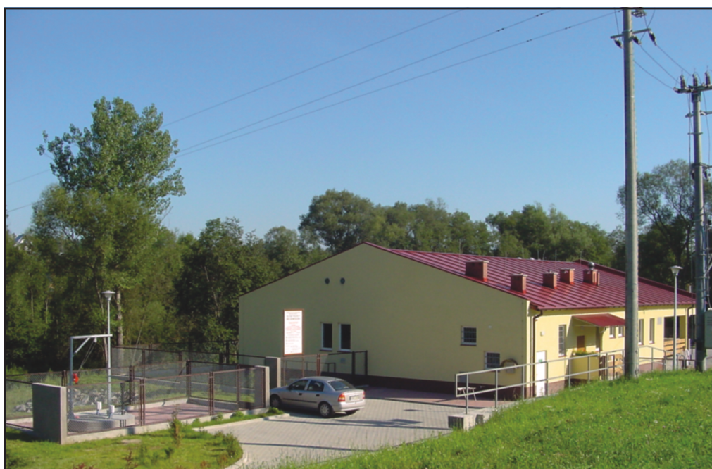
Oczyszczalnia ścieków w Rokicinach Podhalańskich
